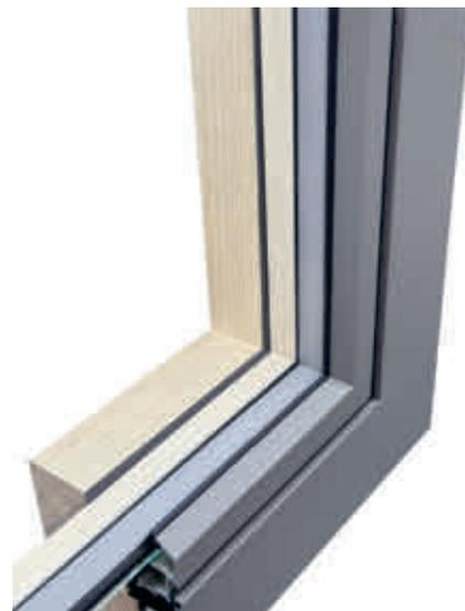
Selbst die Anpassung auf die Innen- und Außenseite eines Holz/Aluminium-Fensters ist möglich. Foto: Rottler und Rüdiger
